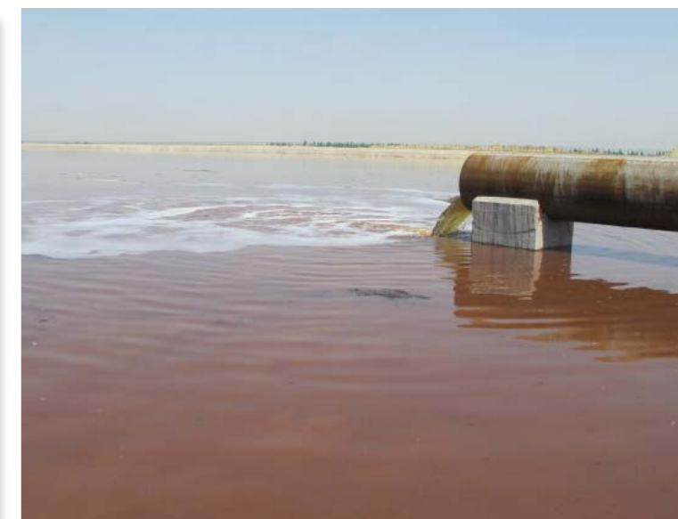
Abwasserrohr der Firma Shiyao Zhongrun Pharmaceutical Copyright: Shao Wenjie
